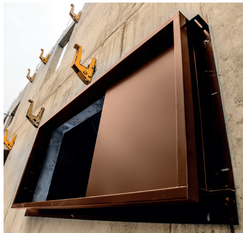
Chantier St Ouen - 417 précadres
